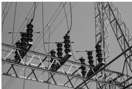
Figura. Seccionador de tres columnas de 220 kV.
