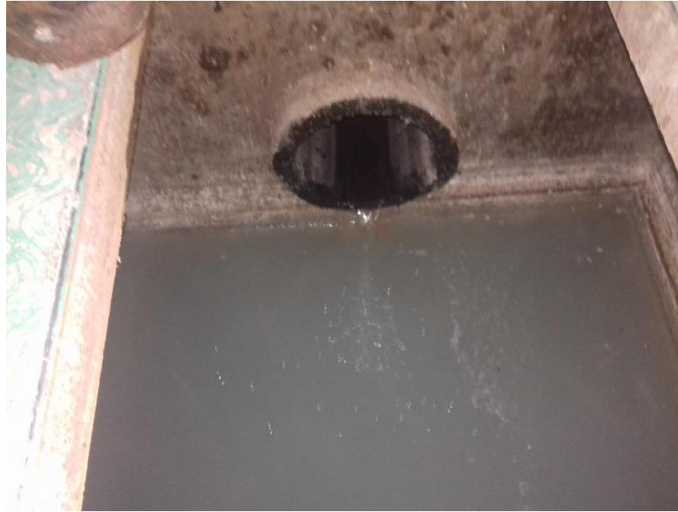
Propuesta de mejora. Sustituir la coladera de 2" por una de 8" la cual descargaría a un registro de acero inoxidable de 40 X 40 X 40 cm y este a su vez se conectaría a la tubería de 8" aumentando el área de descarga de agua. A su vez a la salida de dicha tubería en el registro de proceso se colocaría una válvula check de acero Inoxidable para evitar el ingreso de plagas por la coladera de 8".
